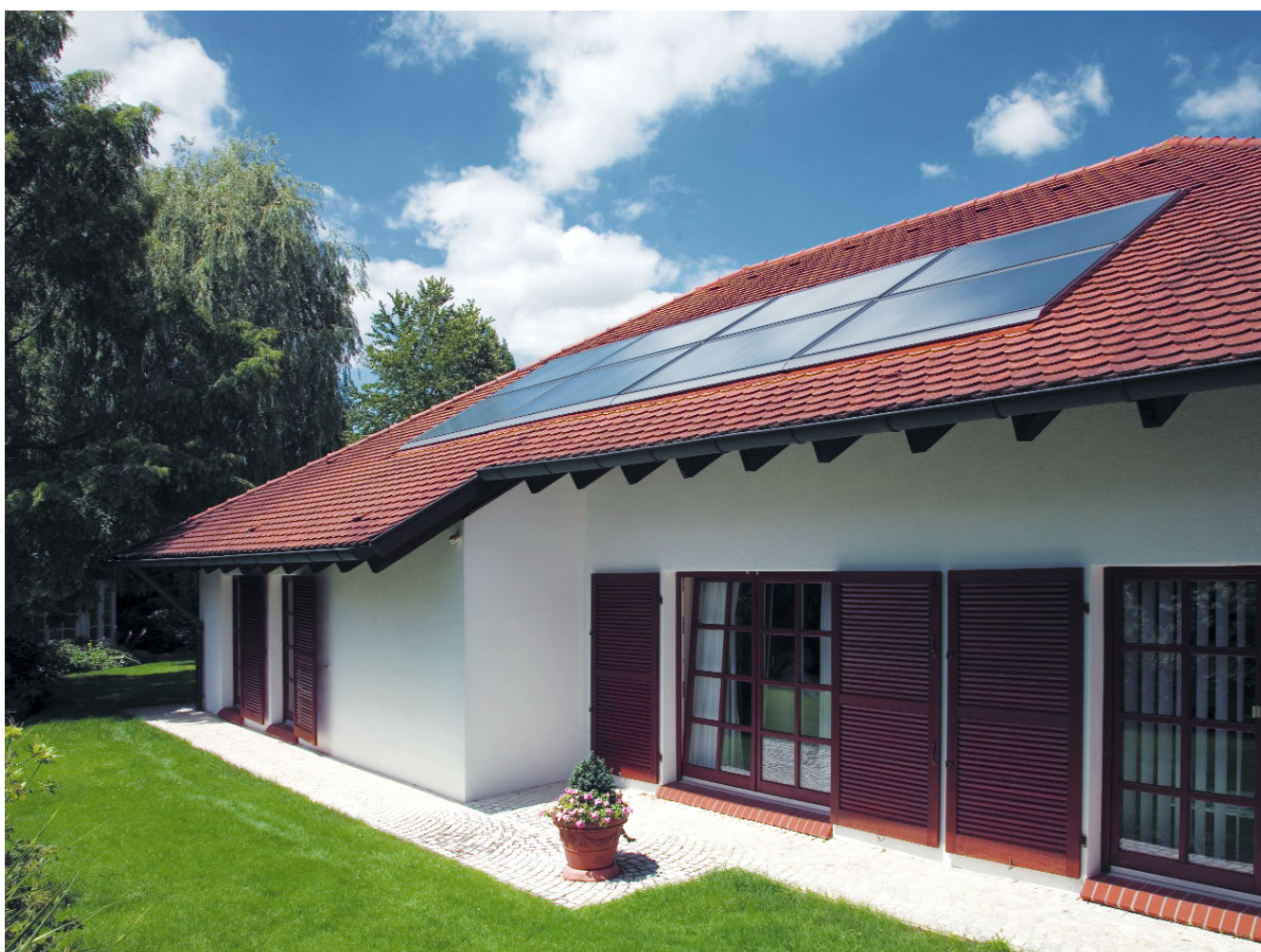
Intégration parfaite des capteurs solaires Weishaupt dans la toiture
